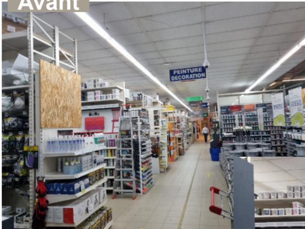
Installation composées de réglottes avec des tubes fluorescents de 2x58W: - Soit une consommation de 130W par réglotte
